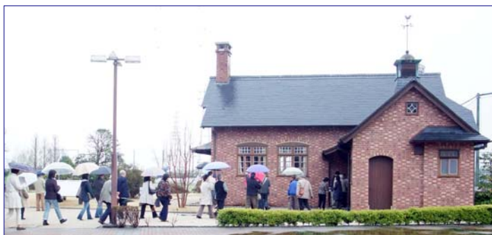
レンガ造りの誠之堂と清風亭。渋沢栄一にゆかりのある建物で、東京から大寄公民館に移築されました。
